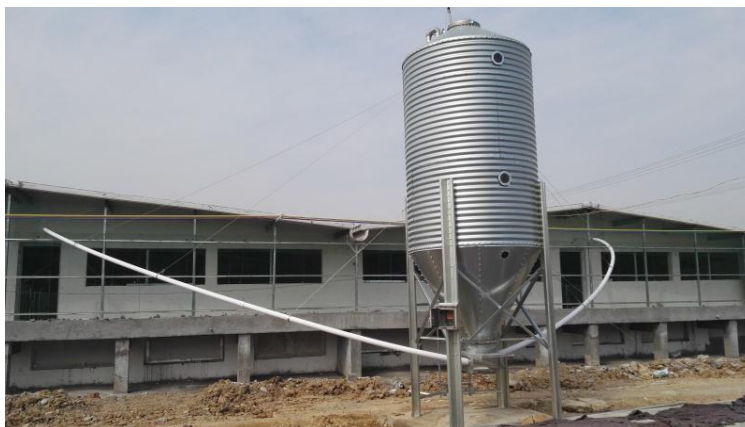
图2.3-5 饲料料罐（料罐至各养殖单元）
